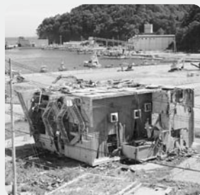
津波と液状化の影響を受け、パイルごと抜け落ち倒れた巡航船のチケット販売所(女川町)
