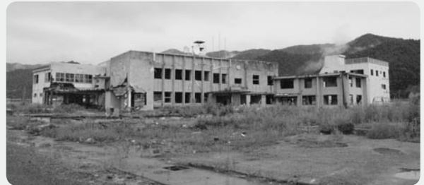
大槌町役場。まだ、解体されていない建物もあります
